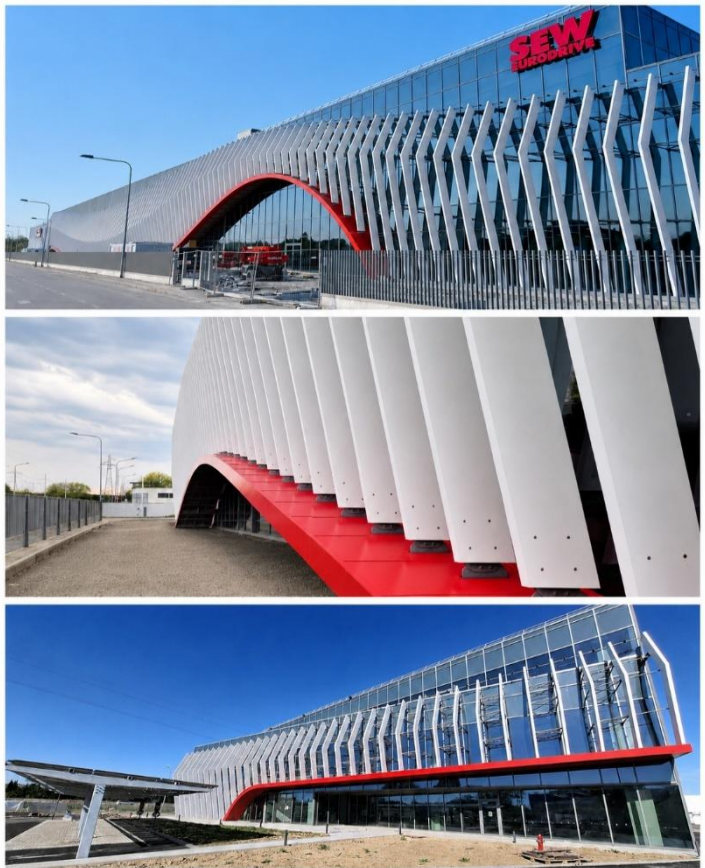
Facciata a lamelle verticali e involucro vetrato
